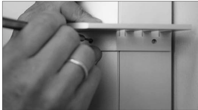
2. Bohrlöcher anzeichnen.
