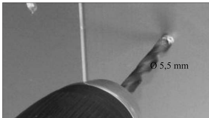
4. Löcher bohren, dazu das Duschpaneel aufklappen.
