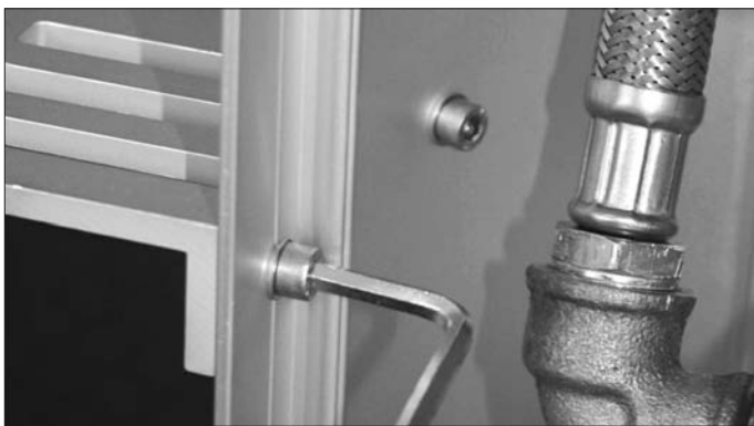
5. Ablageschale anschrauben.
