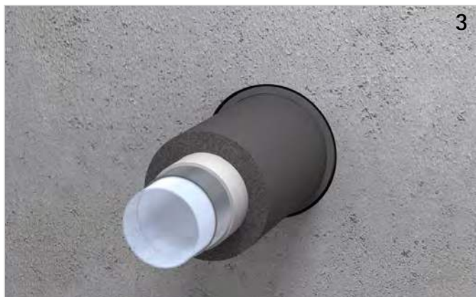
Bandage in Bauteilöffnung schieben (bündig mit Bauteiloberfläche).
